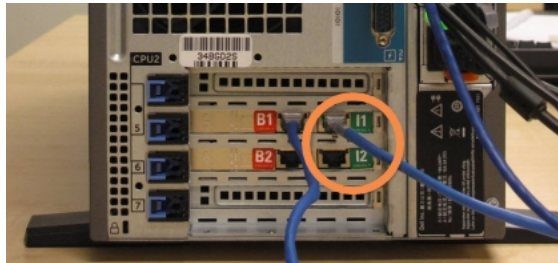
Slika 16-3: Priklučci za instrumente kontrolera
